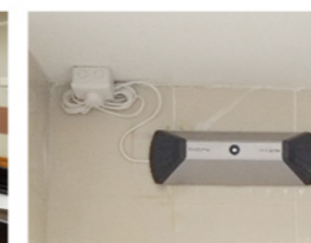
安裝 Biozone 空氣淨化機
