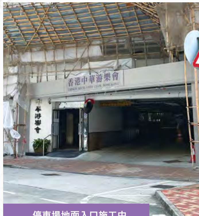
停車場地面入口施工中
